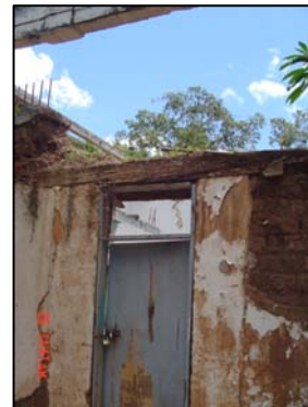
Oficina en mal estado, presentando el muro derribado e inexistencia de techo
