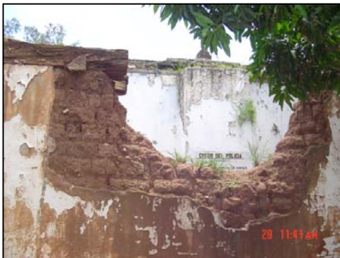
Oficina en mal estado, presentando el muro derribado e inexistencia de techo
