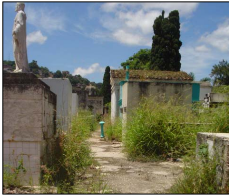
Presencia de Maleza en los corredores del cementerio
