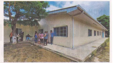
El edificio de la consulta externa del Hospital Gabriela Alvarado era remodelado, pero nadie sabía sobre el proceso de la obra.
