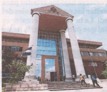
SEDE. Edificio del TSC en Tegucigalpa.
