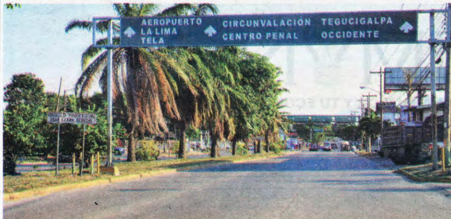
La reparación de la Avenida Circunvalación iniciará en las próximas semanas.
