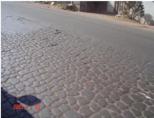
En un 100% de la longitud<sup>6</sup>, (94 KM en dos secciones) la capa de rodadura de la carretera muestra signos evidentes de fatiga y de envejecimiento del asfalto.- Los principales indicios de la presencia de fatiga son pequeños poliedros que se asemejan a la piel del cocodrilo.
