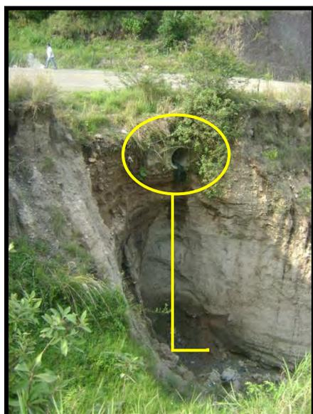
Durante el recorrido se encontró que está a punto de derrumbarse el cabezal de salida de la alcantarilla construida en la estación 37+080, que de continuar cediendo el talud de apoyo de este tramo de la carretera terminaría afectando directamente la trocha izquierda.
