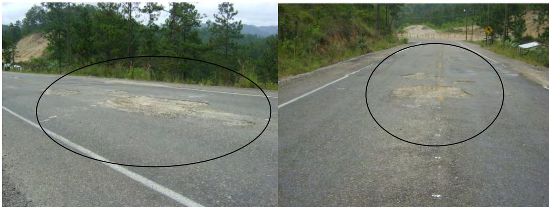
En la estación 6+000 se encontró una peladura en el carril izquierdo, según análisis realizado por el personal técnico de éste Tribunal, podría ser indicativo que el *ligante asfáltico se ha endurecido o que el contenido de ligante es deficiente, el uso de agregados sucios o muy absorbentes, deficiencias durante la construcción, así como la iteración de agentes agresivos tales como algunos derivados de petróleo inclusive en ocasiones la acción del agua.*
