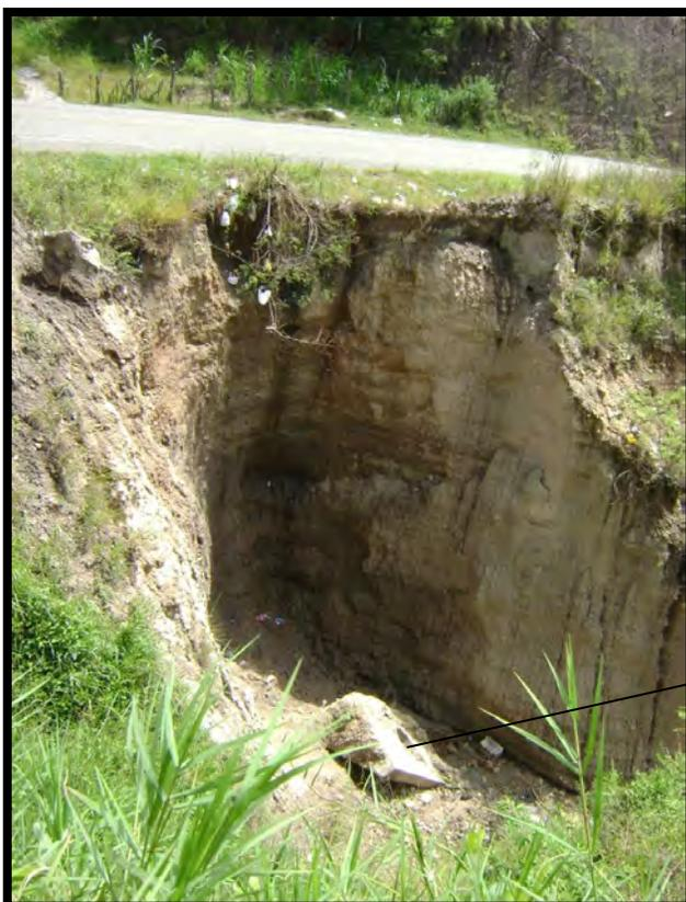
Con fecha 02 de junio, 2010, mediante Oficio No. 179-2010-Presidencia, se comunicó a SOPTRAVI que el cabezal de salida de la alcantarilla construida en la estación 37+080 se encontraba a punto de derrumbarse, esto como consecuencia del deslizamiento del suelo que formaba el talud de apoyo a la carretera, de
