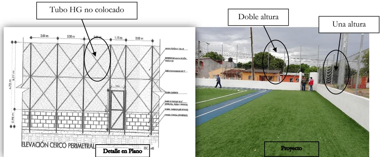
Imagen #5: Comparación del detalle en plano contratado con la colocación de malla ciclón en sitio.
