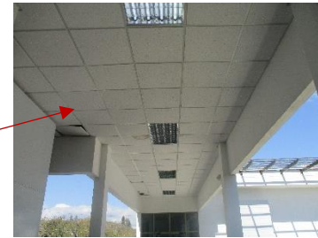
Ilustración 13- D-13 Cielo falso lamina fibra minera 12x4.
