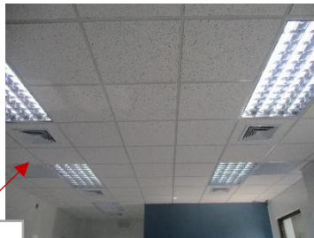
Ilustración 12- J-1 Suministro e instalación de cielo falso de fibra mineral.
