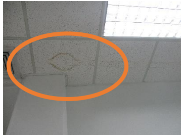
Ilustración 5- Vestíbulo contiguo a ascensor
