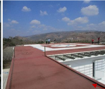
Ilustración 11- D-11- Impermeabilización de losa de Puente con carpeta asfáltica.
