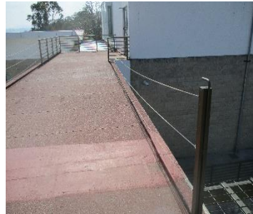
Ilustración 11- D-11- Impermeabilización de losa de Puente con carpeta asfáltica.
