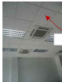
Ilustración 12- J-1 Suministro e instalación de cielo falso de fibra mineral.
