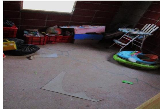
Imágenes 4 y 5: Elementos fisurados por asentamientos en rellenos y construcción de muros de retención
