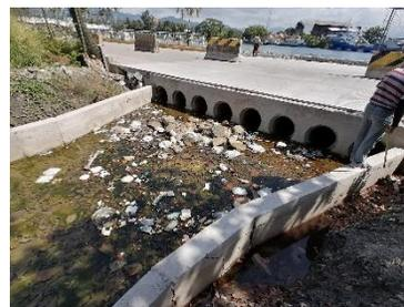
Ilustración 3- Suministro e instalación de TCR 24" Tipo V
