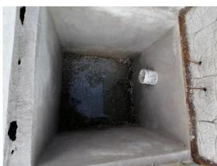
Ilustración 4- Caja de registro sin tubería de salida
