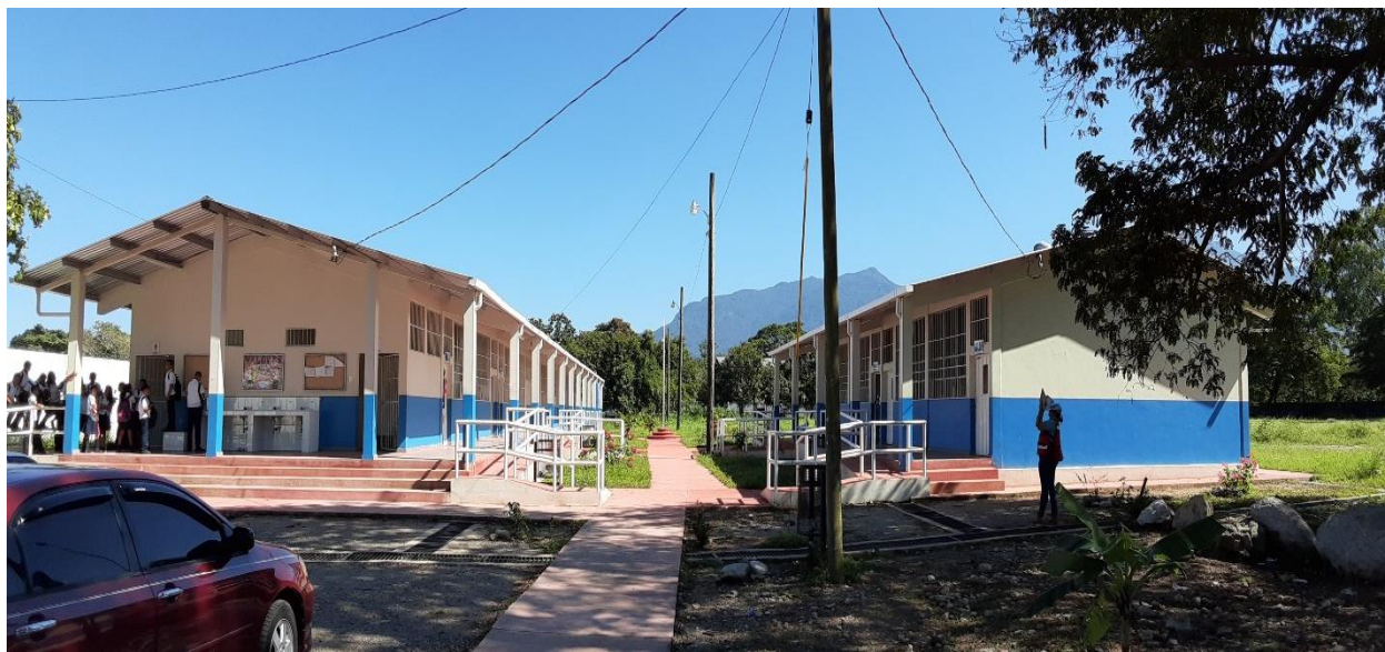
Imagen 3: Instalaciones de la Ampliación del Instituto Oficial La Ceiba
