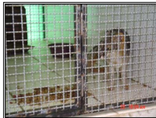
Fotografías 16 y 17. Jaulas del área de cuarentena construidas con material inadecuado. Asimismo, presentan recubrimiento inadecuado por la parte exterior.
