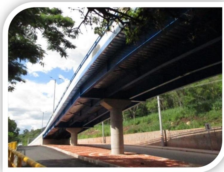
*Pavimento de Losa de Concreto y Barrera New Jersey*
