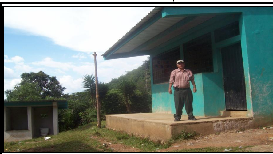
Proyecto Construcción de Aula Escolar Comunidad Cerro los Altos
