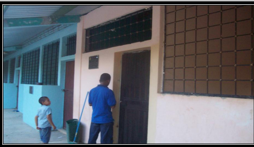
Proyecto Construcción de Aula Escolar Comunidad la Unión
