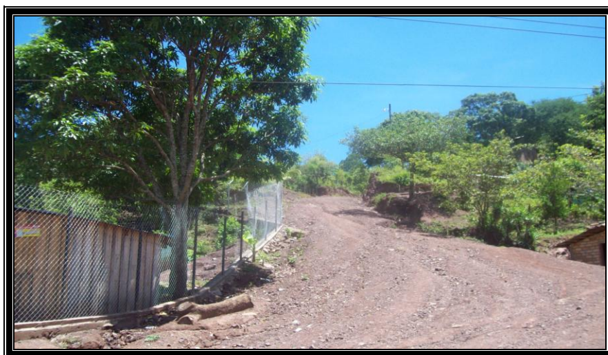
Proyecto Reparación de Caminos Vallecillo, Trinidad de Quebradas
