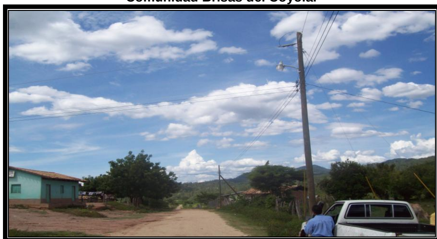
Proyecto de Electrificación Comunidad de Agua Blanca
