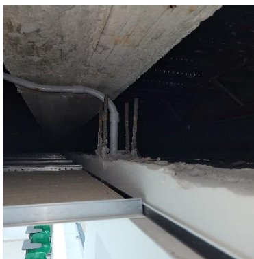
Ilustración 4- Vigas de concreto
