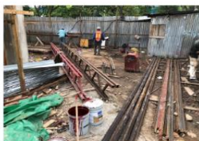
imagen 6. Sostén de obra
