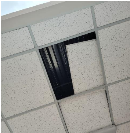
Ilustración 6- Lámina de cielo falso movido
