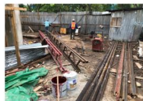
imagen 6. Sostén de obra
