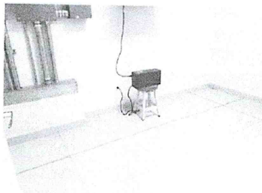
Imagen de Cuarto eléctrico Primer Nivel
