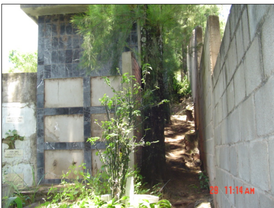
Fotografía 15. Nicho dentro de la franja interna de tres metros en la que no deben realizarse inhumaciones.
