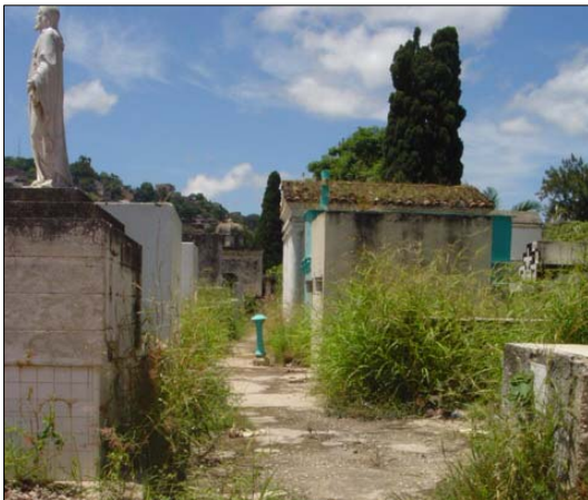
Fotografía 3. Presencia de Maleza en los corredores del cementerio General
