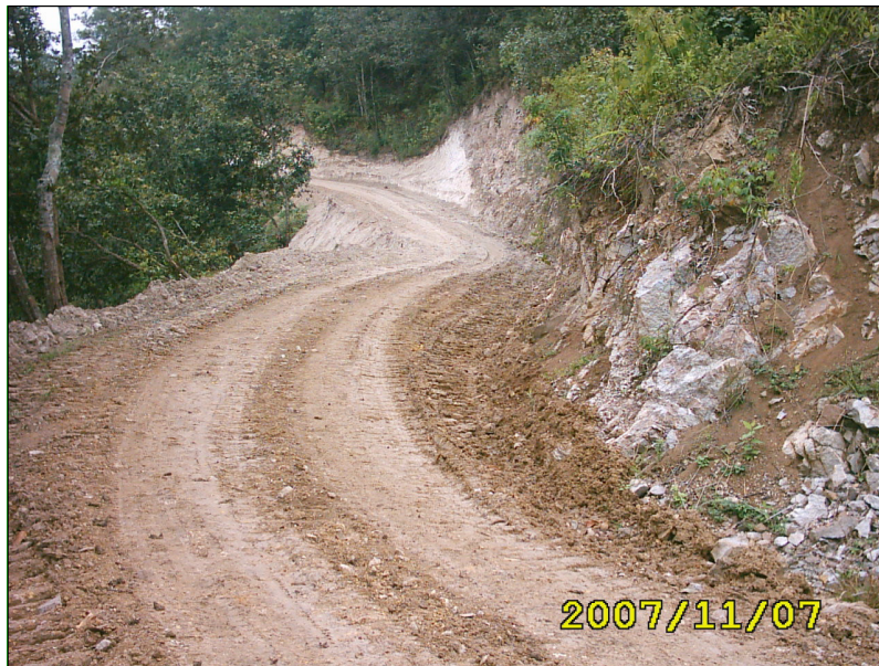
Proyecto Tramo Carretero La Laguna El Sastre
