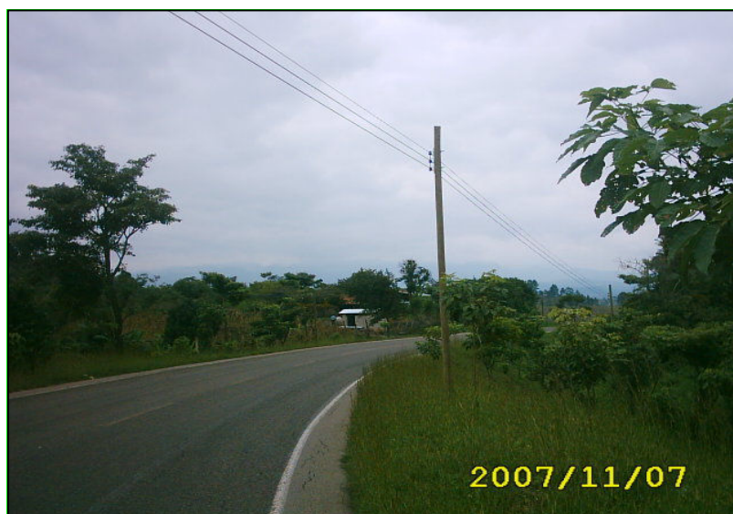
Proyecto de electrificación EL ACAN
