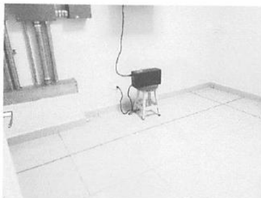
Imagen de Cuarto eléctrico Primer Nivel
