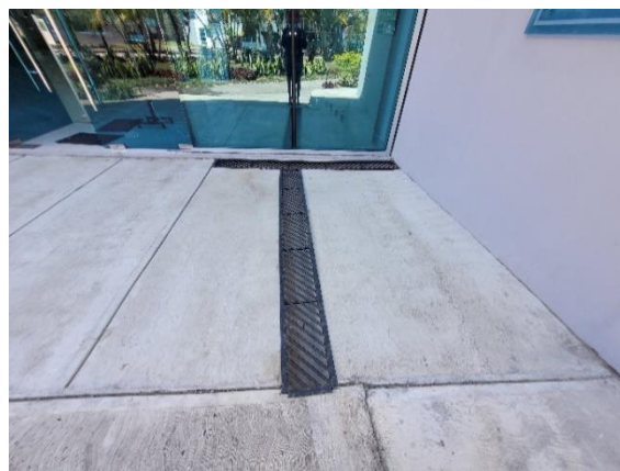
Ilustración 5- Drenaje de Aguas Lluvias
