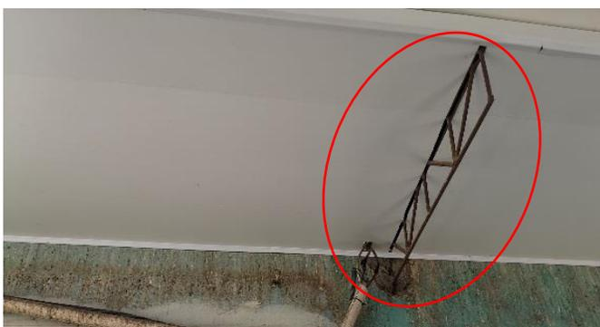
**Imagen 2:** se puede observar los joist existentes sin restauración con pintura anticorrosiva.
