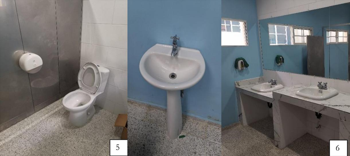
**Imagen 5:** Los inodoros suministrados e instalados no corresponden con la descripción y especificación técnica los cuales solicitaban inodoros con fluxómetro; tal como se usan para sitios de uso al público y los lavamanos colocados **son de uso doméstico con llaves poco resistentes, de baja calidad y sin pedal.**
