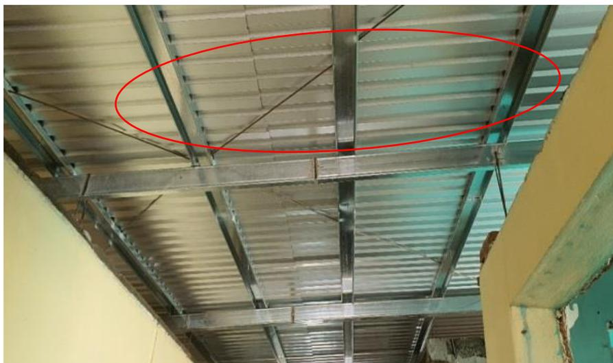
**Imagen 1:** Muestra la colocación de la canaleta horizontal y no de perfil, con una manera inadecuada de colocación de canaletas galvanizadas.
