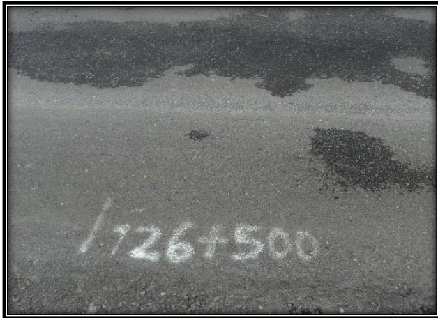
Ilustración 8- Estación donde se encuentra ubicado el proyecto
