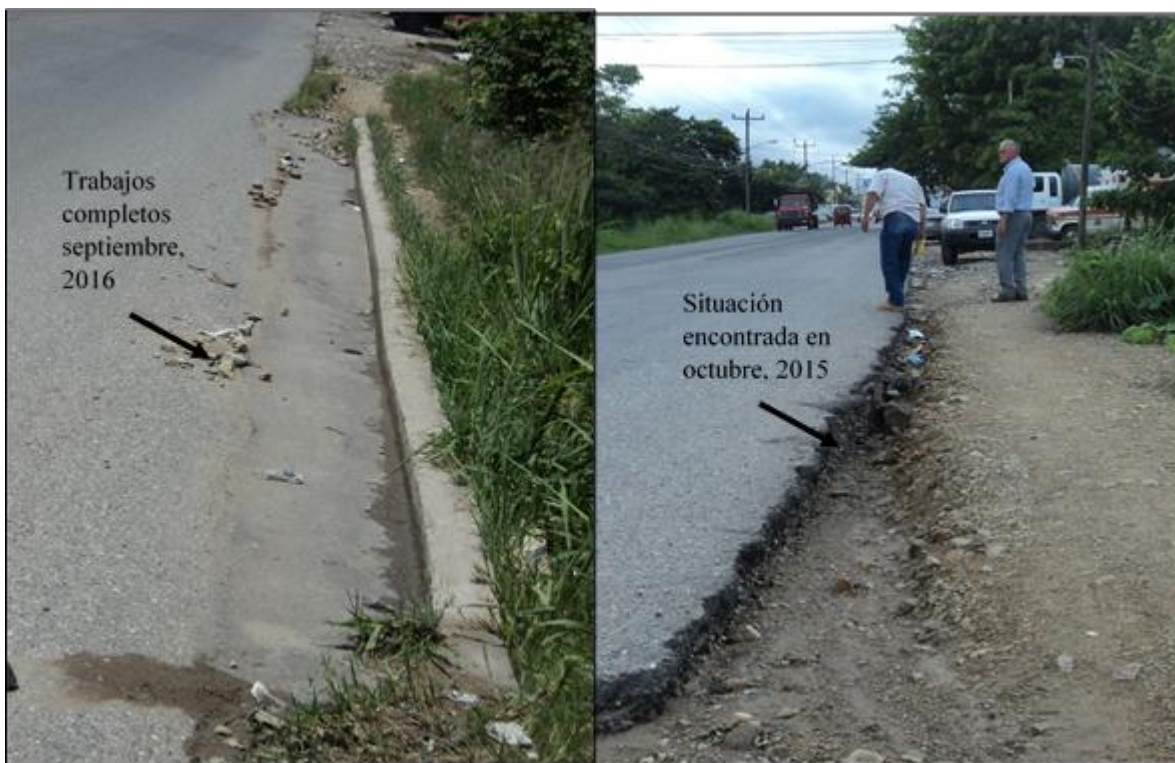
Ilustración 10- Obra subsanada en el KM 105
