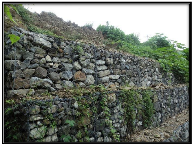
Ilustración 2- Reparación de Talud con Gaviones
