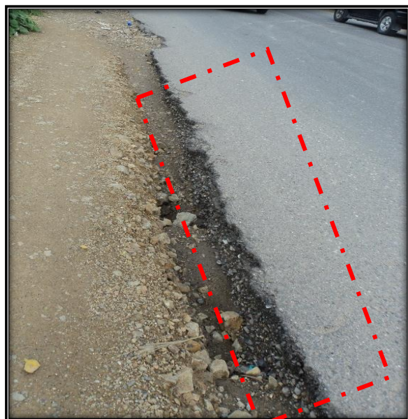
Ilustración 7- Falla Desintegración de Bordes
