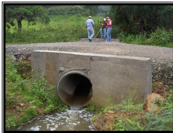
Alcantarilla lateral TCR Ø 30" ubicada al final de la pavimentación al lado derecho
