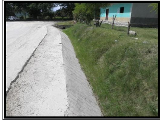
Ubicación de muro al final del pavimento Concreto Ciclópeo
