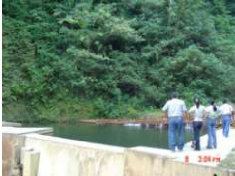
Represa La Danta, construida por el SANAA en la Comunidad El Zapote
