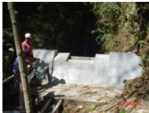
Sistema de Captación de Agua, en construcción por el proyecto PRRACAGUA en la Comunidad El Zapote
