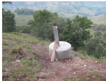
Base de la pata de la Torre
