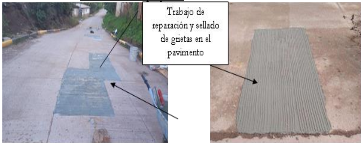
Vista de áreas reparadas en el pavimento hidráulico, en Aldea Rancho Grande, Esquíás, Comayagua.
