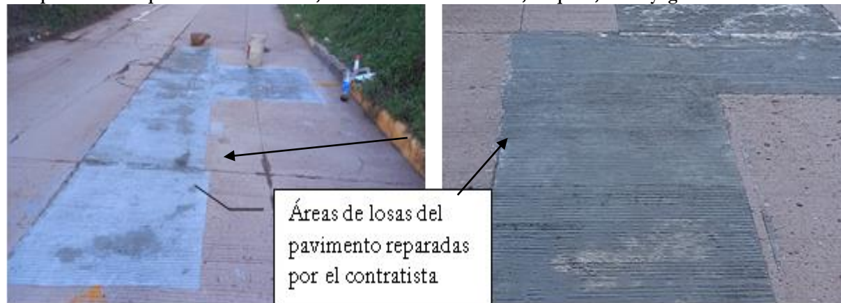
Vista de áreas reparadas en el pavimento hidráulico, en Aldea Rancho Grande, Esquíás, Comayagua.
