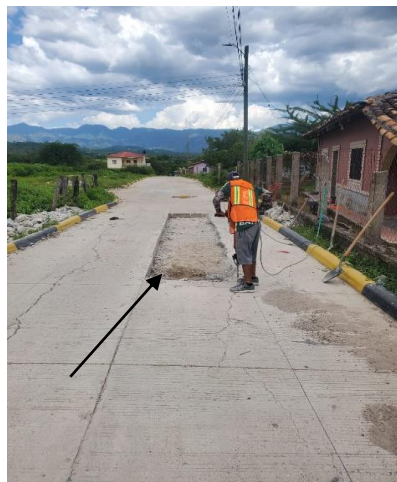
Imágenes que muestran los avances en las actividades de reparación del proyecto de pavimentación de concreto hidráulico que están siendo ejecutadas por el contratista.
