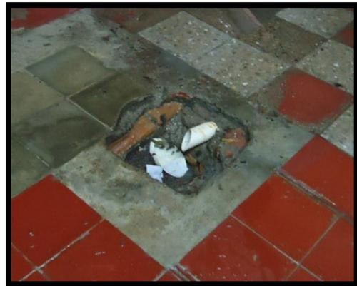
**Imagen No. 10** Tubería en mal estado (Inciso k)
