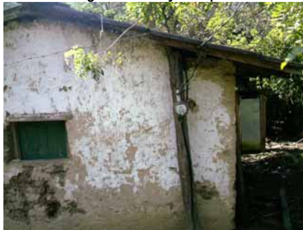
La imagen muestra un contador en casa de habitación en la Comunidad de El Zapote
