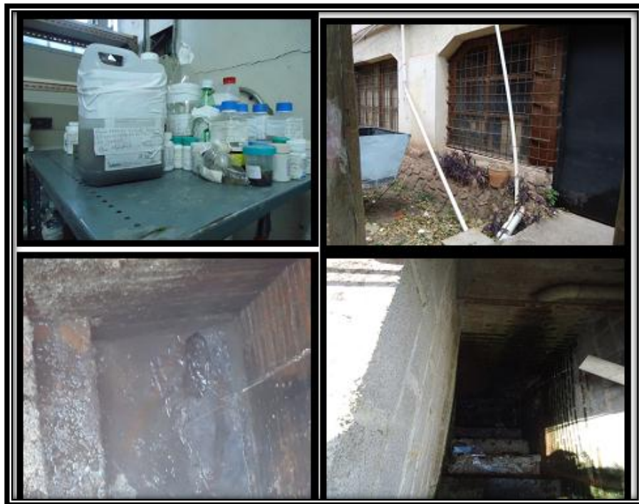
Imagen N° 2. Obsérvese que los líquidos generados en áreas críticas son depositados en el alcantarillado público.
