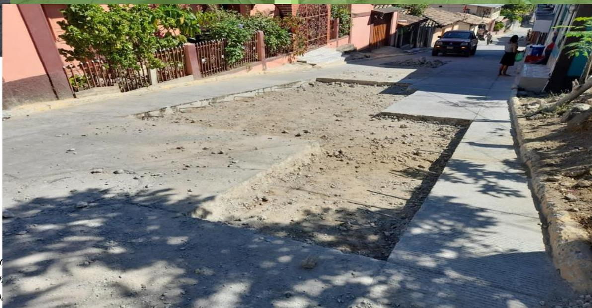
*“Se realizó la subsanación de los bordillos y la losa de pavimento en la calle José Marro. Se efectuó un nuevo levantamiento de las dimensiones del bordillos y de la losa del pavimento, y se comprobó en campo que estas actividades si cumplían en cantidad y calidad, respecto a las cantidades y especificaciones técnicas contractuales.”*
