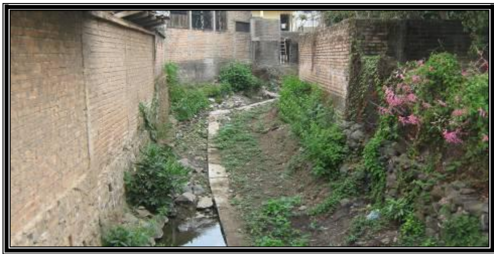
La imagen nos muestra las cámaras de oxidación y los trabajos de ampliación y Saneamiento del sistema de alcantarillado realizado con fondos ERP
