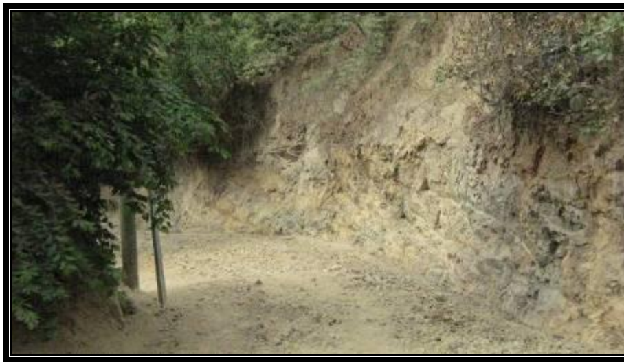
La imagen muestra la colocación de postes para el tendido eléctrico y la reparación de caminos con fondos ERP-2008 en comunidad San Marcos
