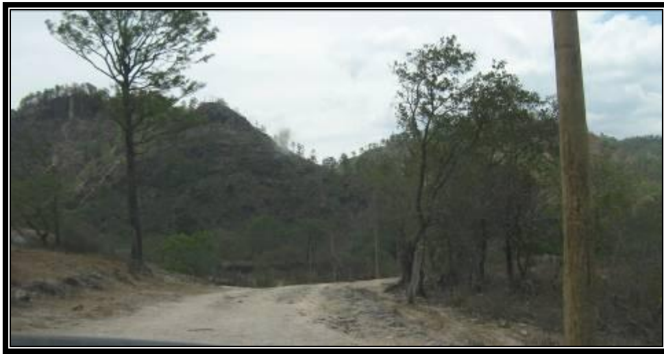
La imagen nos muestra los trabajos realizados en la reparación de la carretera que conduce a la Aldea los Nanzales
