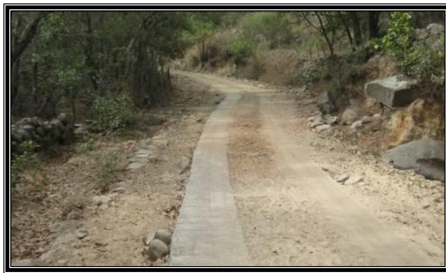
La imagen nos muestra los trabajos realizados en la reparación de la carretera que conduce a la comunidad de Sabana de Encima.
