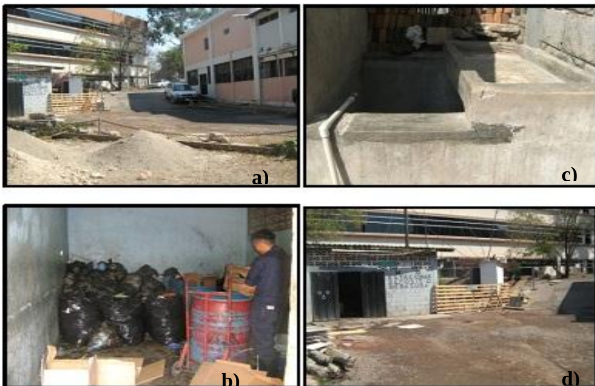
Imagen N° 7: En la imagen se puede observar la ubicación del almacén temporal de desechos frente a las ventanas de la cocina, a la vez no está señalizado, la pileta no posee grifo, el personal no cumple con las medidas de higiene y seguridad.
