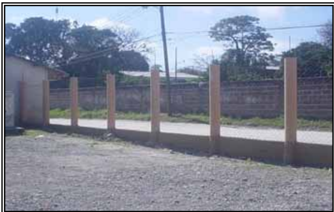
Imagen que muestra la cerca perimetral construida
