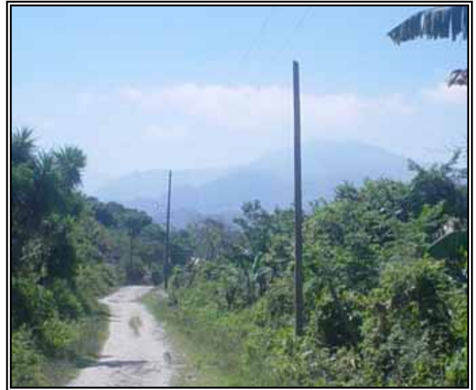
Las imágenes muestran la colocación de postes de luz eléctrica en la Comunidad de Potrerillos
