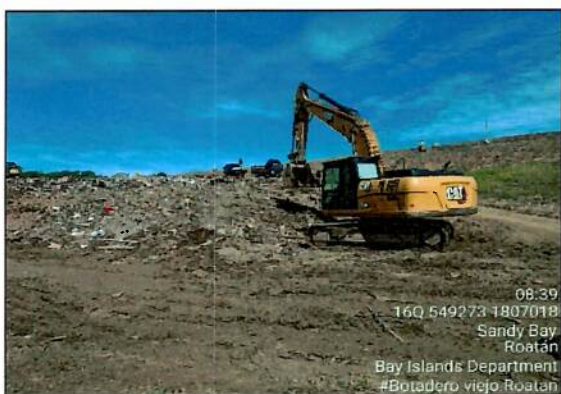
Ilustración 5. Cierre técnico, botadero Roatán
