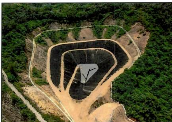
Ilustración 6. Nuevo Relleno Sanitario de Roatán
