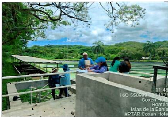
Ilustración 9. Planta de Tratamiento de aguas residuales ubicada en Coxen Hole
