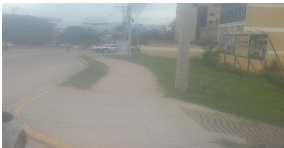
Estacionamiento y edificio Torre La Libertad
