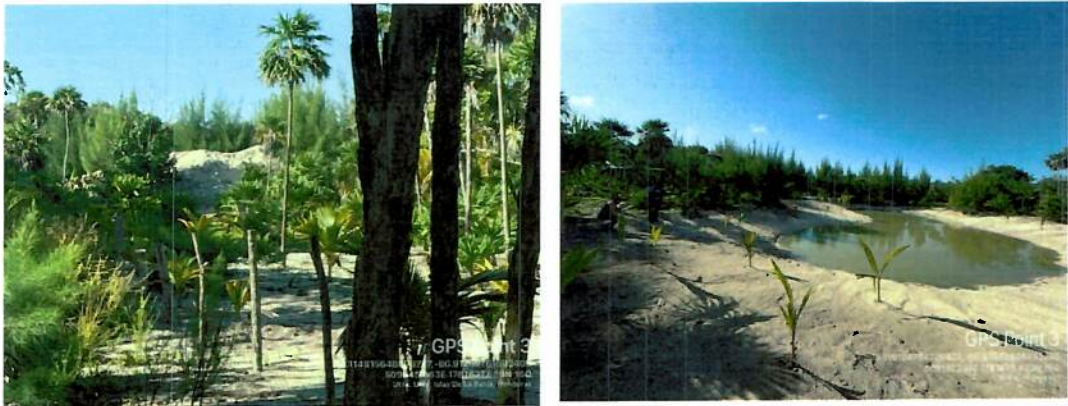
Ilustración 11. Montículo de arena destinado para el relleno del humedal y laguna artificial.
