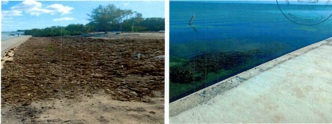
Ilustración 8. Relleno, rampla de concreto y remoción de pasto marino
