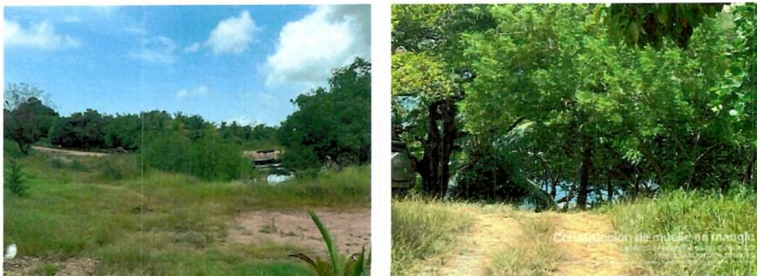
Ilustración 9: Construcción de muelle Calabash Bight
