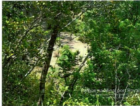
Ilustración 5. Apertura de calle en la zona núcleo Parque Nacional Port Royal, zona del Picachito
