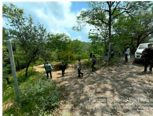
Ilustración 6. Apertura de calle en la zona núcleo Parque Nacional Port Royal, Sector de Diamond Hill.
