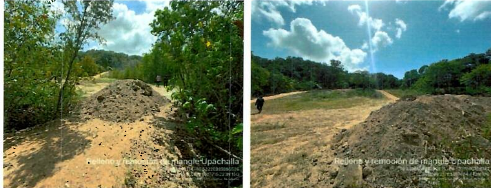
Ilustración 6: Relleno y remoción de mangle Upachaya
