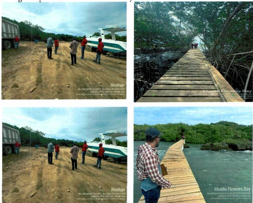
Ilustración 7: Relleno en bosque de mangle y Construcción de muelle Flowers Bay
