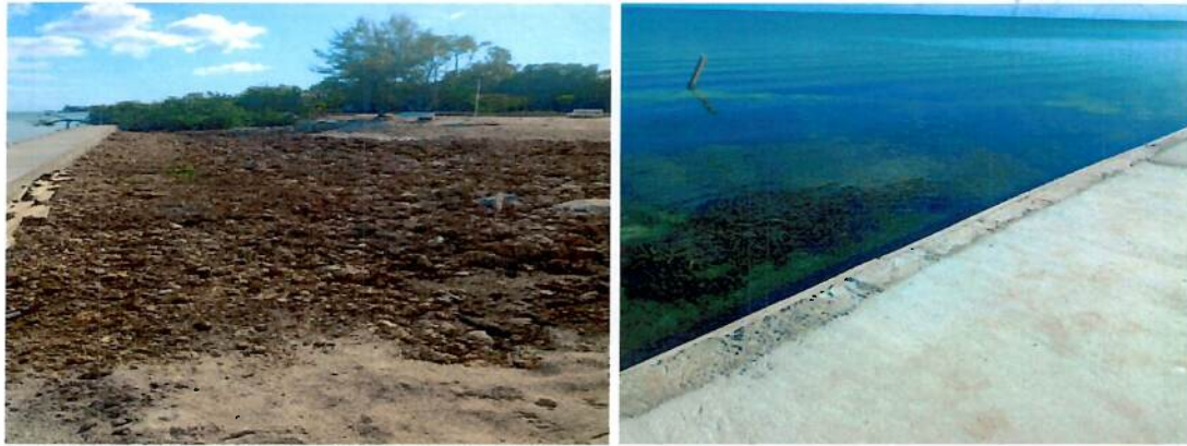
Ilustración 15: Relleno, rampla de concreto y remoción de pasto marino, Chepa Beach, Utila. Esta infraestructura tiene una finalidad turística.
