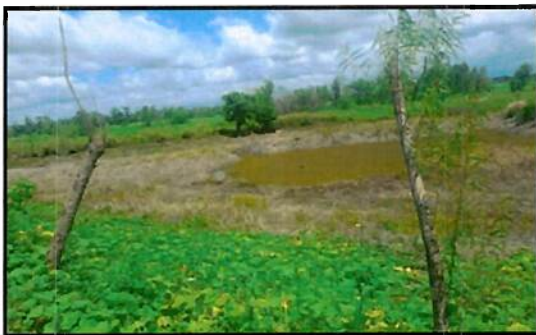
Ilustración 27. Necesidad de reparación por filtración en Bordo Montañuela
