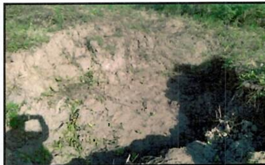
Ilustración 31. Necesidad de reparación de Bordo del Canal San Carlos por abertura de boquetes
