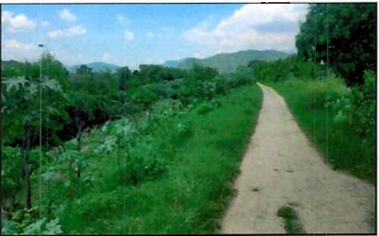
Ilustración 48. Necesidad de limpieza de taludes y remoción de cultivos, Bordo Sector La Mesa, Álvaro Martínez
