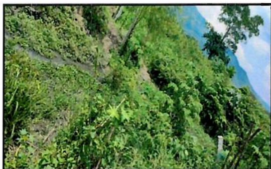
Ilustración 41. Necesidad de limpieza del cauce, Canal comunidad El Vajuco
