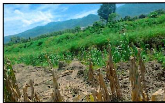
Ilustración 62. Necesidad de limpieza y mantenimiento del ancho de sección del cauce, Bordo Río Ulúa margen derecho sur
