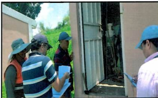
Ilustración 30. Necesidad de reparación de bomba de elevación del bordo Sector La Mesa/Álvaro Martínez
