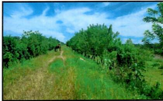
Ilustración 54. Necesidad de limpieza de material vegetativo no deseado, Bordo Río Ulúa
