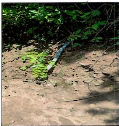
Ilustración 3. Daño al sensor hidrométrico.
