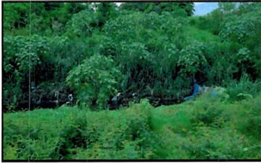
Ilustración 51. Necesidad de desamplificación y mantenimiento ancho de sección, Canal San Carlos
