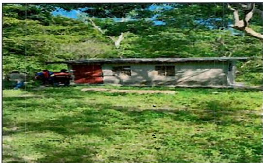
Ilustración 7. Estación Climatológica vandalizada.
