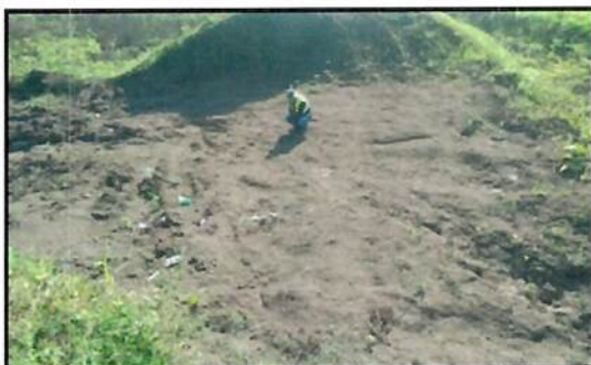
Ilustración 31. Necesidad de reparación de Bordo del Canal San Carlos por abertura de boquetes
