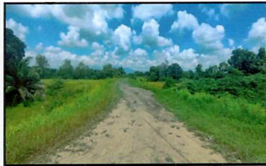
Ilustración 28. Necesidad de reparación por filtración en Bordo La Ceibita
