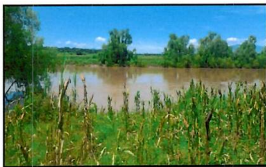
Ilustración 61. Necesidad de limpieza y mantenimiento del ancho de sección del cauce, Bordo Río Ulúa margen derecho norte
