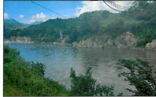
Ilustración 10. Estación que requiere cambio de cable vía y canasta.
