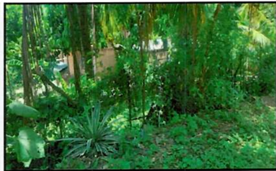
Ilustración 60. Necesidad de limpieza de material vegetativo no deseado, y viviendas cercanas a Bordo del Canal Maya
