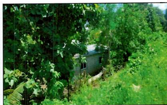
Ilustración 7. Presencia de viviendas en Bordo Río Ulúa, Colonia Omonita
