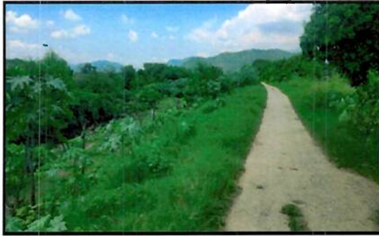
Ilustración 1. Necesidad de construcción de gaviones en el Bordo del Sector Valle Escondido
