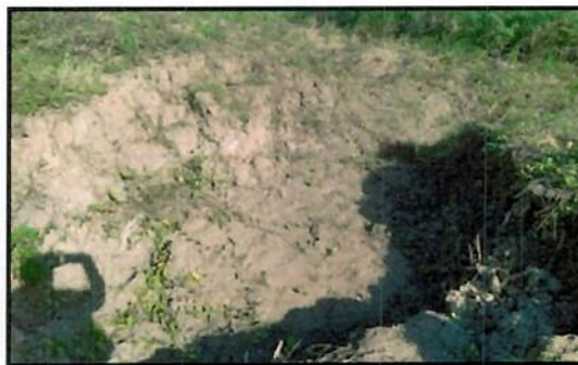
Ilustración 5. Necesidad de reparación de Bordo del Canal San Carlos por abertura de boquetes
