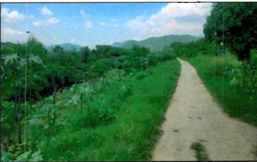
Ilustración 11. Necesidad de limpieza de taludes y remoción de cultivos, Bordo Sector La Mesa, Álvaro Martínez
