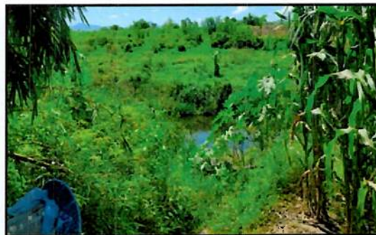
Ilustración 7. Necesidad de reparación de alcantarilla en Canal Camping
