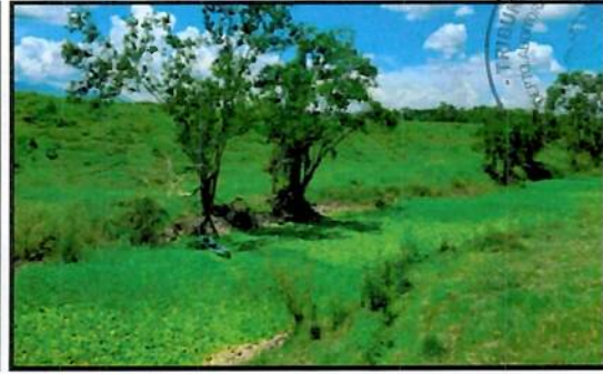
Ilustración 9. Falta de mantenimiento de ancho de sección desasolvamiento, Canal Marimba
