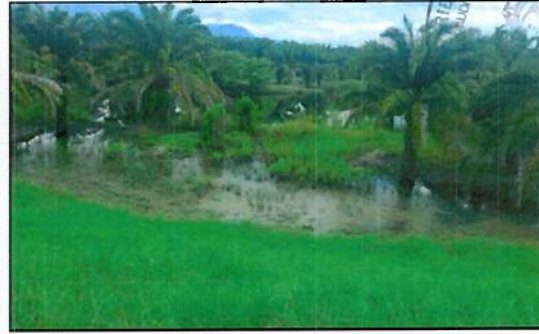
Ilustración 6. Necesidad de reparación de filtraciones en varios puntos del Bordo Río Ulúa margen derecho sur aguas abajo
