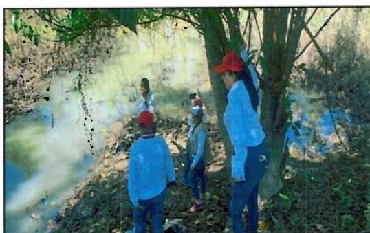
Ilustración 11. Necesidad de limpieza, desasolvamiento y mantenimiento del ancho de sección del cauce, Bordo Río Pelo
