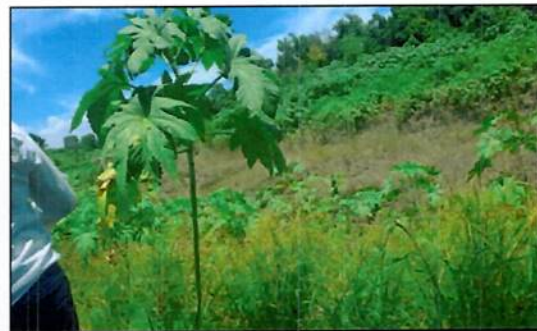
Ilustración 12. Necesidad de limpieza y mantenimiento del ancho de sección del cauce, Canal de Alivio Los Indios y Amapa
