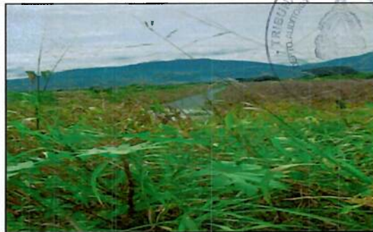
Ilustración 14. Necesidad de limpieza y mantenimiento del ancho de sección del cauce, Canal Guanchias y Canal Palermo
