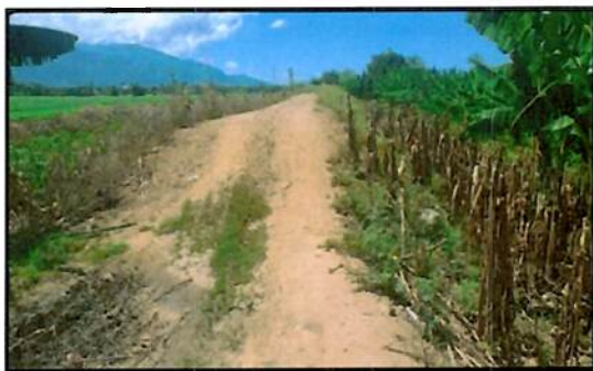
Ilustración 1. Necesidad de concluir elevación Bordo de Canal de Alivio Puente Plateado y Canal Fátima que intercepta con quebrada Corocol.
