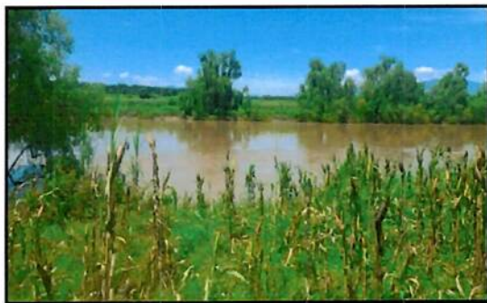
Ilustración 9. Necesidad de limpieza y mantenimiento del ancho de sección del cauce, Bordo Río Ulúa margen derecho norte
