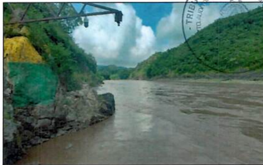
Ilustración 13. La canasta y cable vía para poder aforar están dañado.
