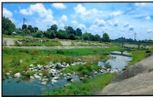
Ilustración 6. Necesidad de limpieza del cauce, Canal Choloma Centro
