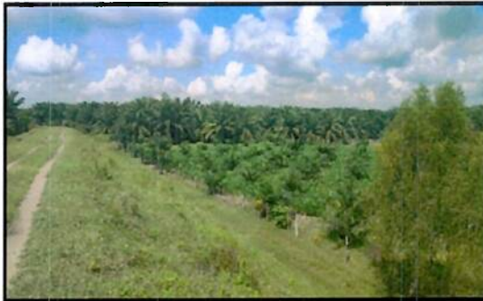
Ilustración 1. Necesidad de reparación por filtración en Bordo Bandera
