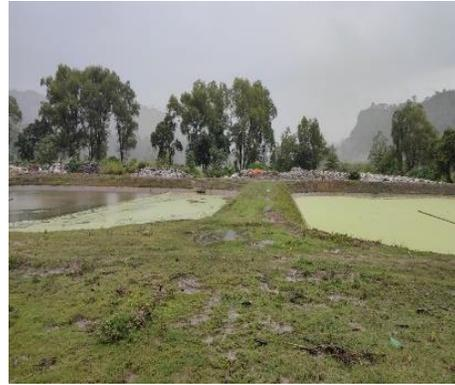
**Segunda laguna de maduración parcialmente colapsada por el exceso de algas.**
