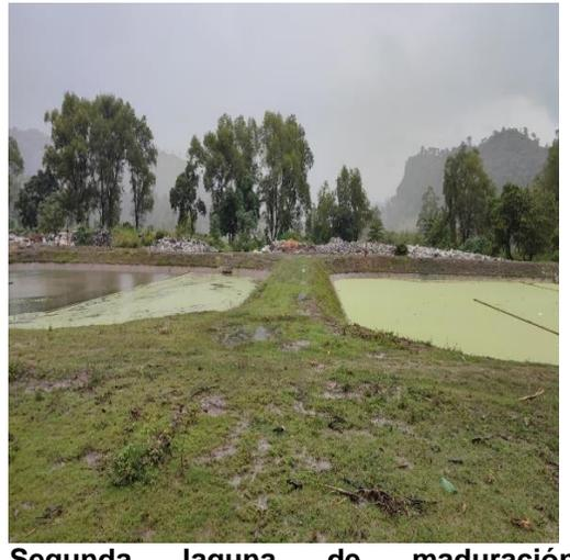
**Segunda laguna de maduración parcialmente colapsada por el exceso de algas.**
