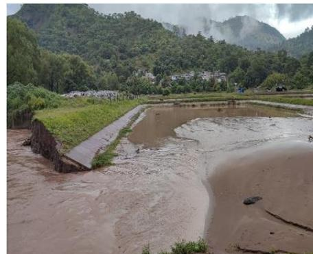
**Laguna de Estabilización colapsada por el desbordamiento del Río Copán.**
