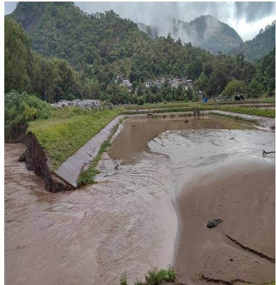
**Laguna de estabilización colapsada por el desbordamiento del Río Copán.**
