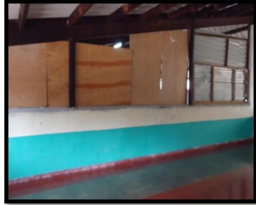
**Imagen No.9** Ventanas y paredes en mal estado (Inciso j) y
