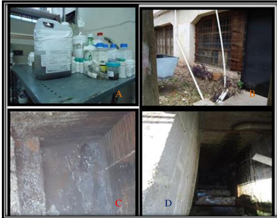
**Imagen N° 2.** Obsérvese que los líquidos generados en áreas críticas, imagen A bajan por los tubos que se observan en foto B y se depositan en cajas de captación de las aguas residuales del alcantarillado público, imágenes C y D, ejemplos de algunos líquidos: sangre, desechos de biopsias, esputos y desechos líquidos de radiología.
