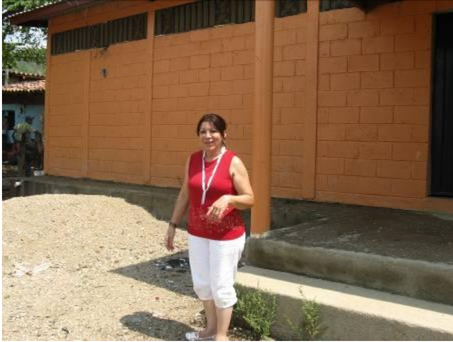
Reparación de escuelas
