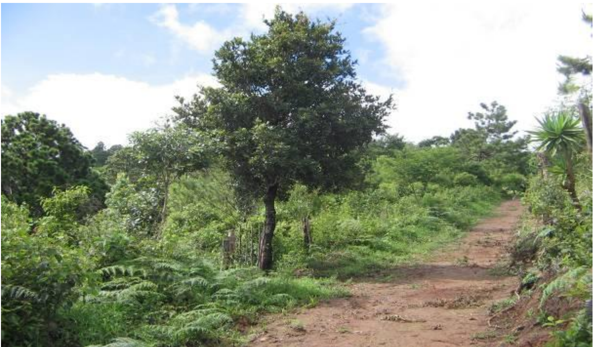
Apertura de Carretera Iguatalla
