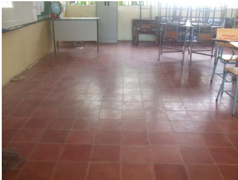
Reparación Escuela José Cecilio del Valle, en la Aldea el Obraje del Municipio de Namasigue, se cambio Techo, Piso y se pinto
